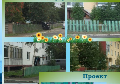
Исходное состояние ограждения многоквартирных домов
